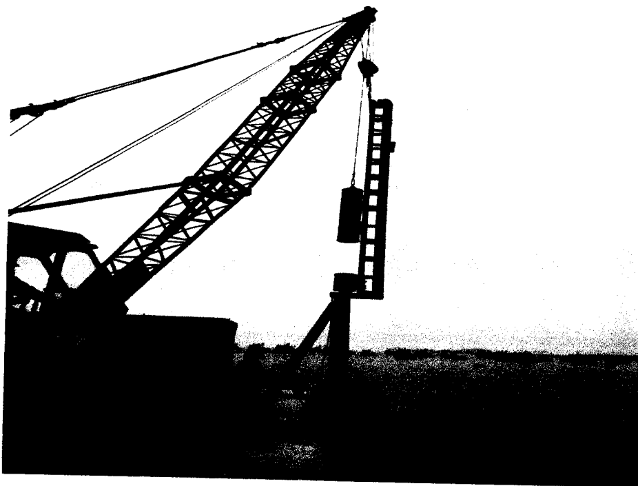
COLOCACION DE MARTILLO E HINCADO DE DE PARANTES METALICOS
