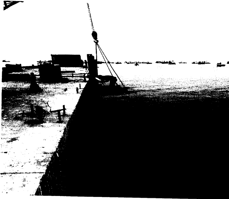
DESCABEZADO DE PILOTES METALICOS
